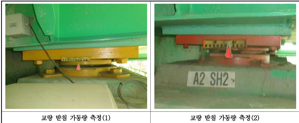
【사진 19.3.18】 교량받침 이동량 측정
