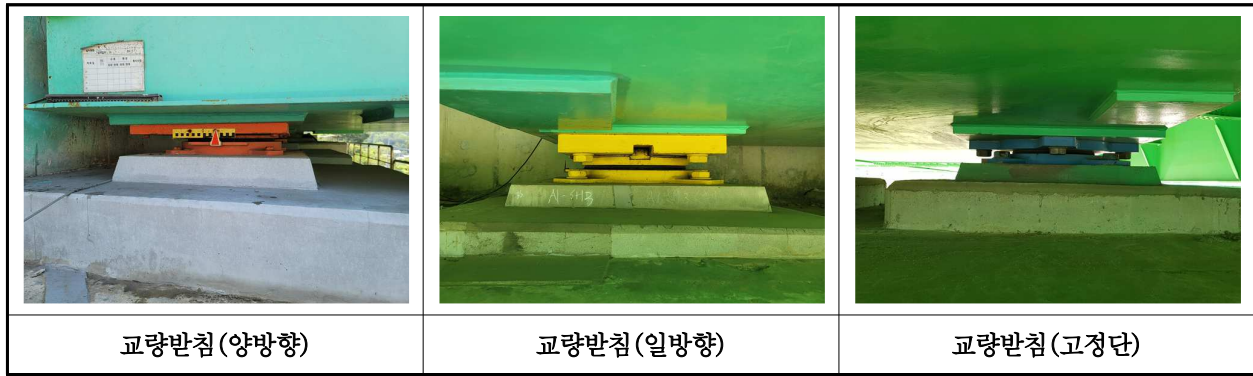
【사진 19.3.15】 교량받침 전경
