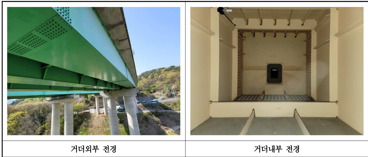
【사진 19.3.4】 거더 전경
