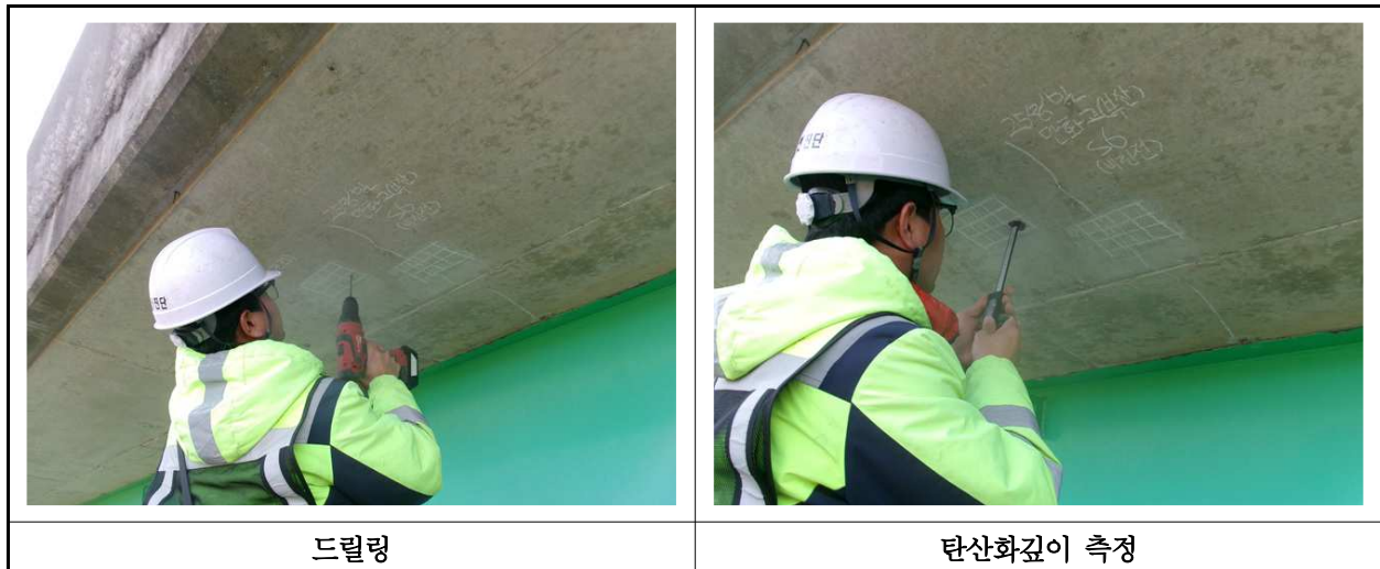
【사진 19.4.3】 탄산화 깊이 측정 현장사진
