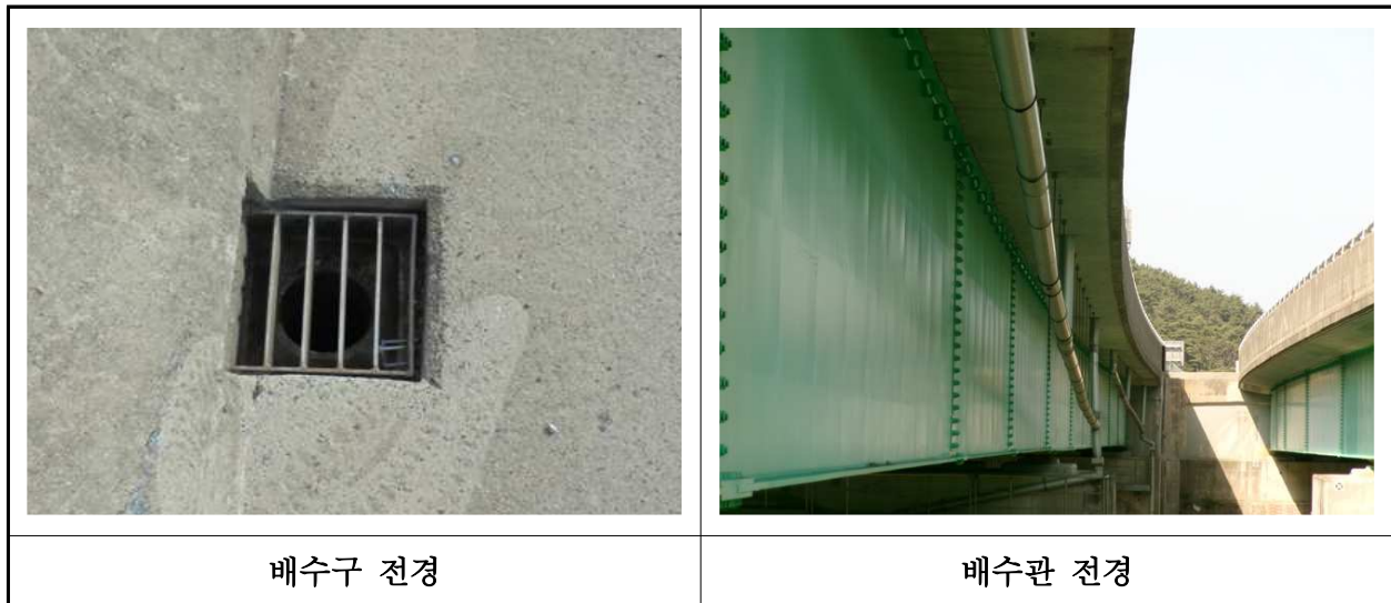
【사진 19.3.24】 배수시설 전경
