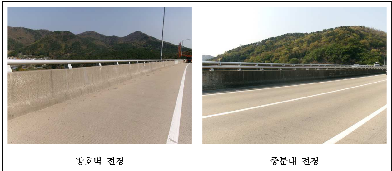
【사진 19.3.26】 방호벽 및 중분대 전경
