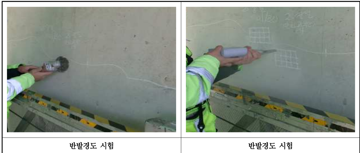
【사진 19.4.2】 반발경도시험 현장사진
