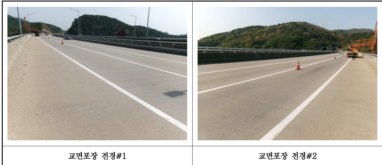
【사진 19.3.22】 교면포장 전경
