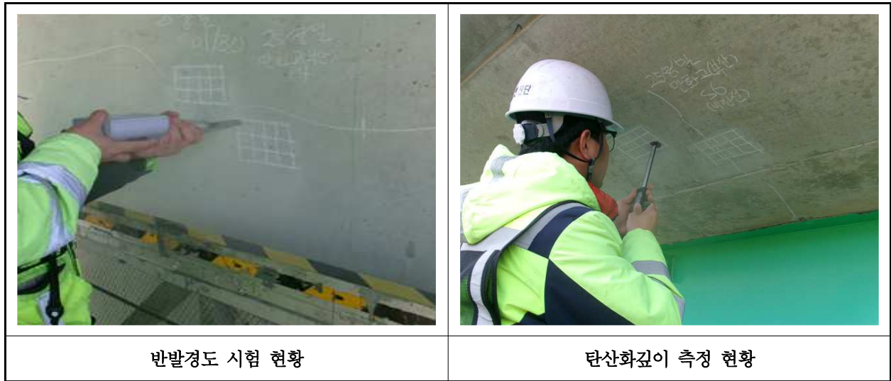
【사진 19.4.1】 콘크리트 내구성조사 현황
