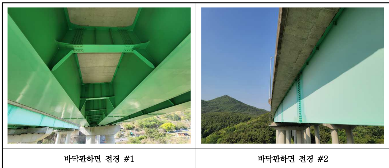
【사진 19.3.2】 바닥판하면 전경
