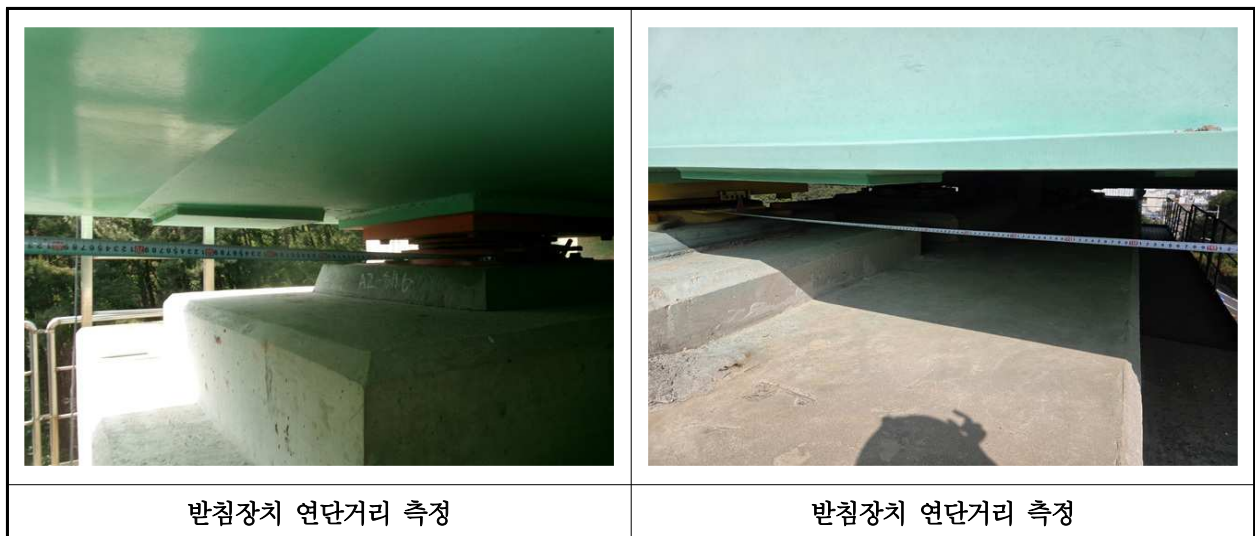
【사진 19.3.17】 교량받침장치 연단거리측정
